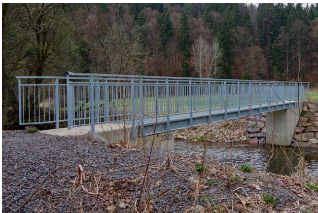
Obnovená lávka přes Tichou Orlici z roku 2019
