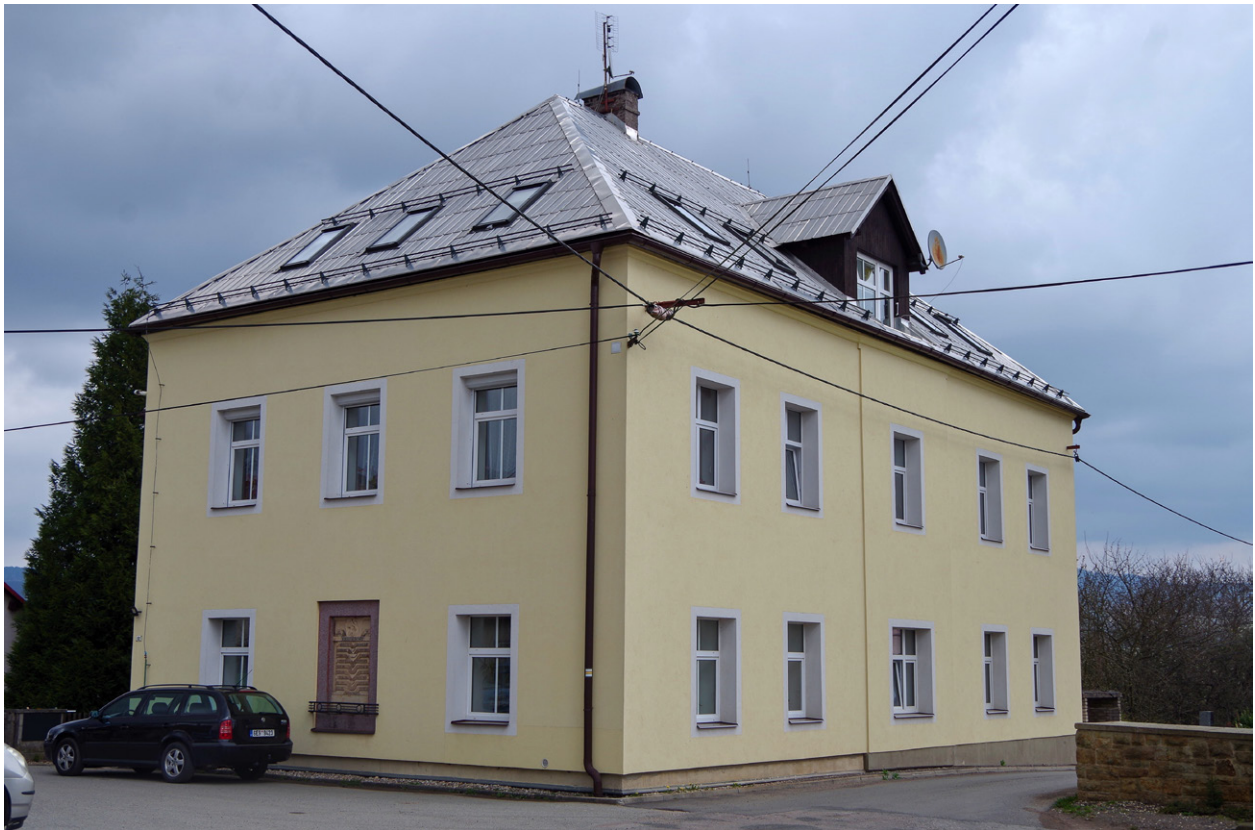
Bývalá škola čp. 92, nyní obecní šestibytový dům
