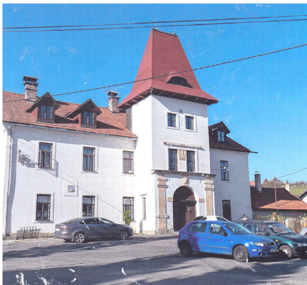
Hostinec pod věží čp. 45 po rekonstrukci kolem roku 2010
