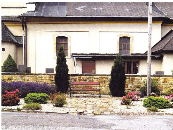
Stavební úpravy hřbitovní zdi a okolí v roce 2013
