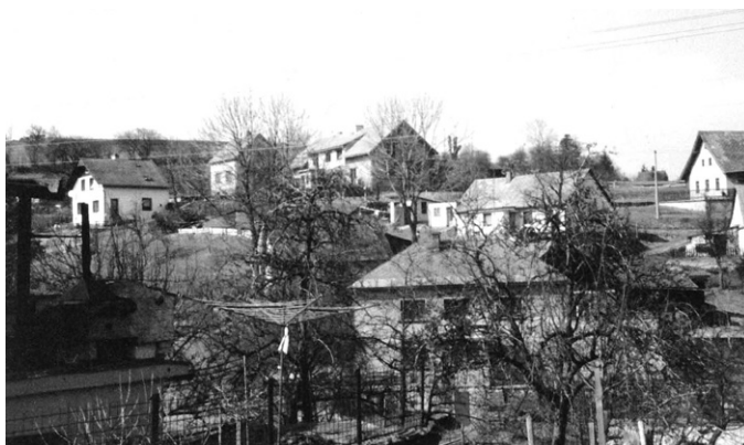
Bývalé sobkovické chalupy zleva: čp. 40, 100, 90, 89, v popředí bývalý zahradnický grunt čp. 52. Stav kolem roku 1990
